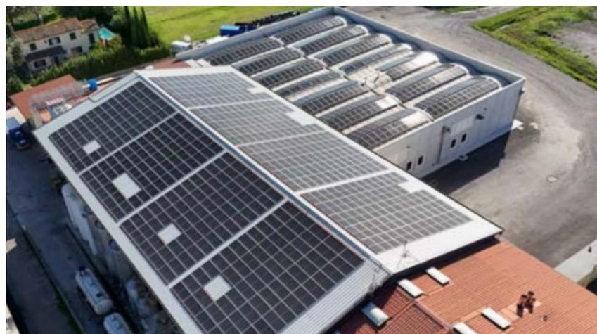
abbassare del 25% il consumo massimo (picco quotidiano) di energia elettrica prelevata da rete. Con il successivo ampliamento previsto e l'aggiunta di altri pannelli, l'efficienza potrebbe arrivare a coprire il 40% della richiesta elettrica nei momenti di picco.
